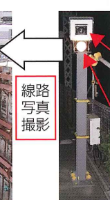
デジタルカメラ 光源用照明 支柱上に設置した デジタルカメラと照明
