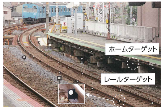
デジカメレールウォッチャーによる計測
