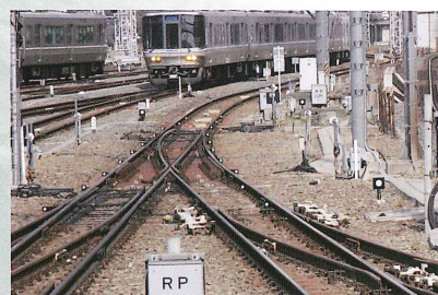
分岐部の軌道計測事例
