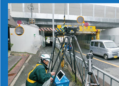
桁の健全度を評価する手法の検査の例
